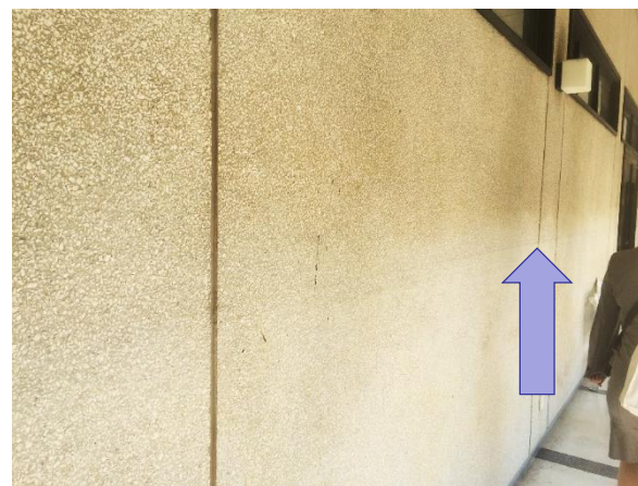
東アジア研究所内の宿泊施設等の壁に、洪水被害の跡が残っていた。
