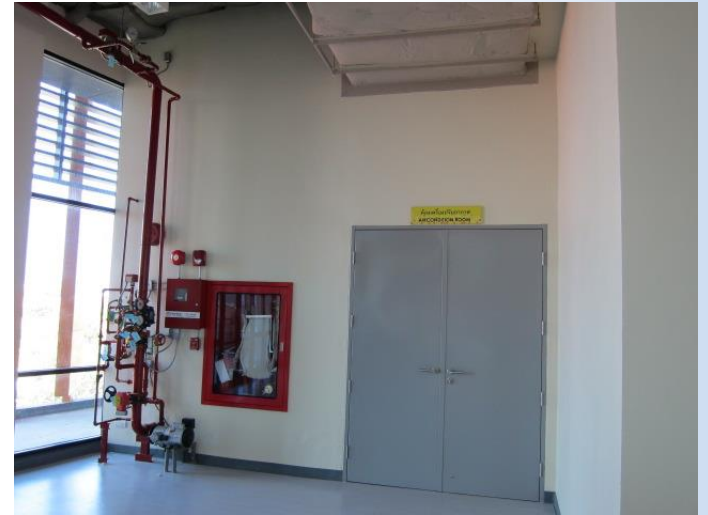
天井や、一步裏に回ると配管がむき出し。
