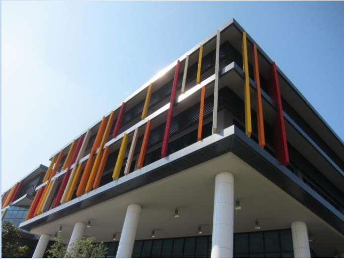
ラーニングセンターの概観。浜松キャンパスの附属図書館の概観に少し似ているがカラフル。
