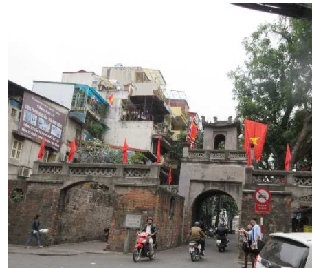
東河門。旧市街に残る旧ハノイ城の門。1749年に建てられ、19世紀に修復されている。
