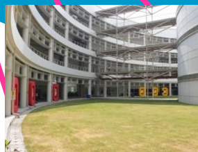
▲社会科学部の建物。中庭側から見た様子。
